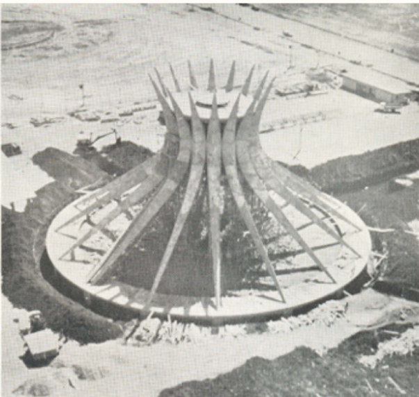
Construcción de la Catedral de Brasília
