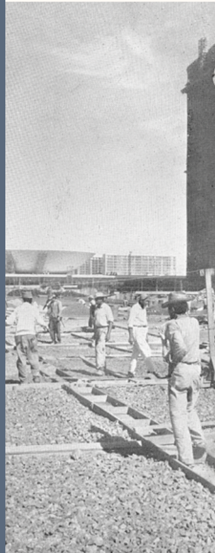
Construcción del Congreso Nacional
