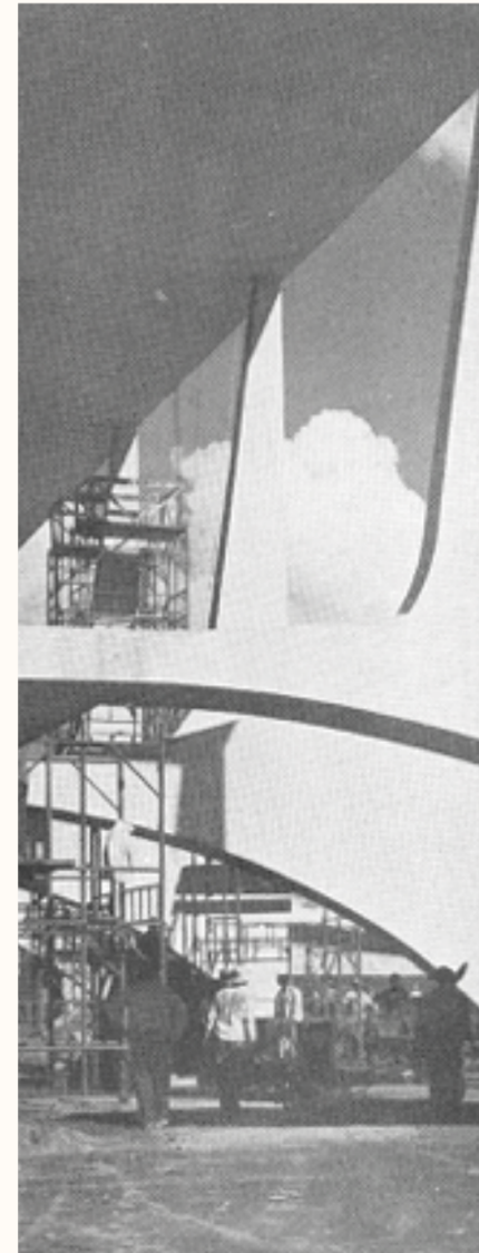
Construcción del Palácio del Planalto
