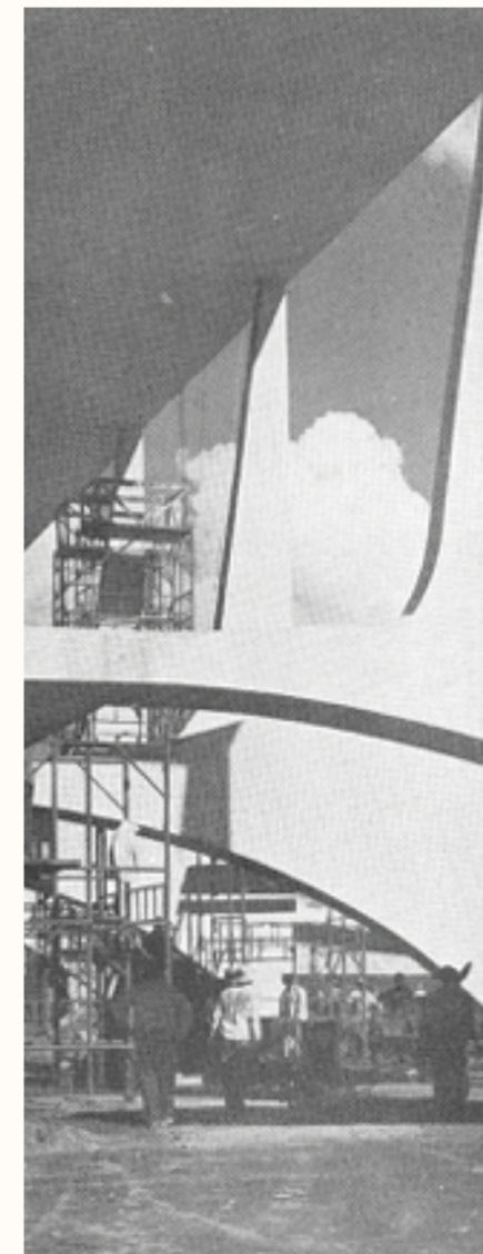
Construcción del Palácio del Planalto
