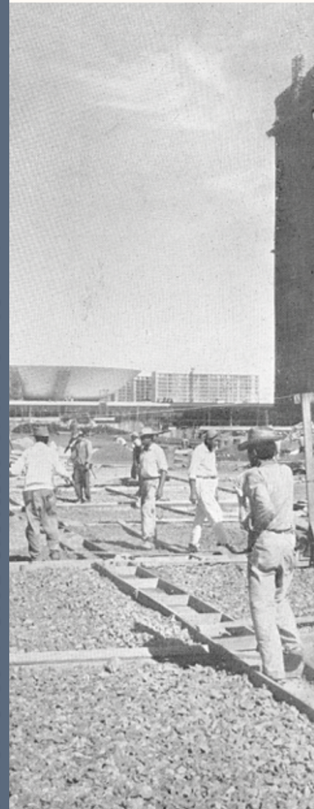
Construção do Congresso Nacional
